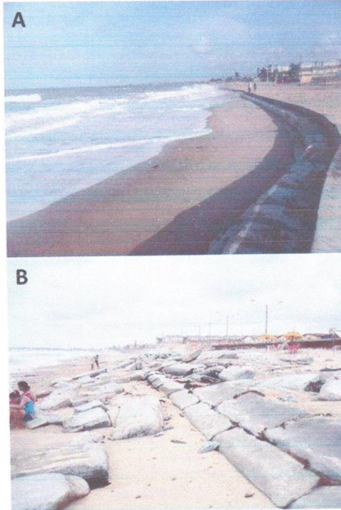
**Figura 33** – Solapamento da estrutura impermeável (Bagwall) e degradação do ambiente praial na Praia de Icarai/CE.
