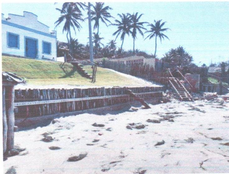
**Figura 19:** Ponto atingido pela erosão sendo protegido por uma estrutura não dissipativa provocando o efeito de transferência do processo erosivo para áreas adjacentes.
