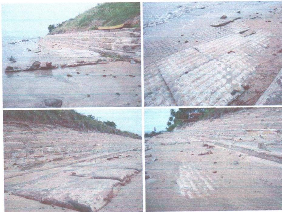
**Figura 32** – Rebaixamento do terreno natural e afloramento da fundação (Praia de Japaratinga/AL).
