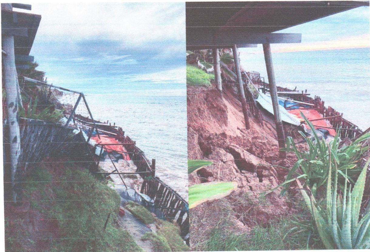
**Figura 27** – Estruturas artesanais de madeiras, totalmente inadequadas à defesa costeira, são arrebetadas pela energia das ondas e marés altas na Praia da Peroba, Icapuí-CE.
