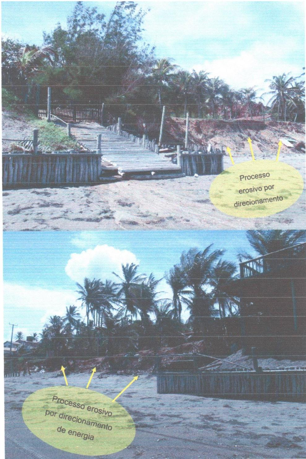
**Figura 23** – Avanço das intervenções direcionando a energia para áreas vizinhas, transferindo o processo erosivo nessas áreas, praia de Peroba, Icapuí-CE.
